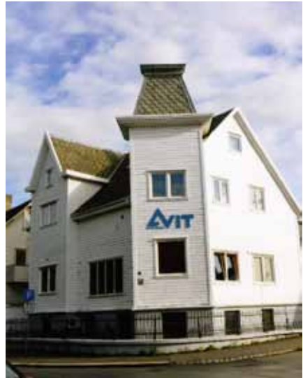
Sandeidgaten 2, fotografert i 2009. Dette var rørlegger Wilhelm Nesslers privatbolig fra århundreskiftet 1900.
